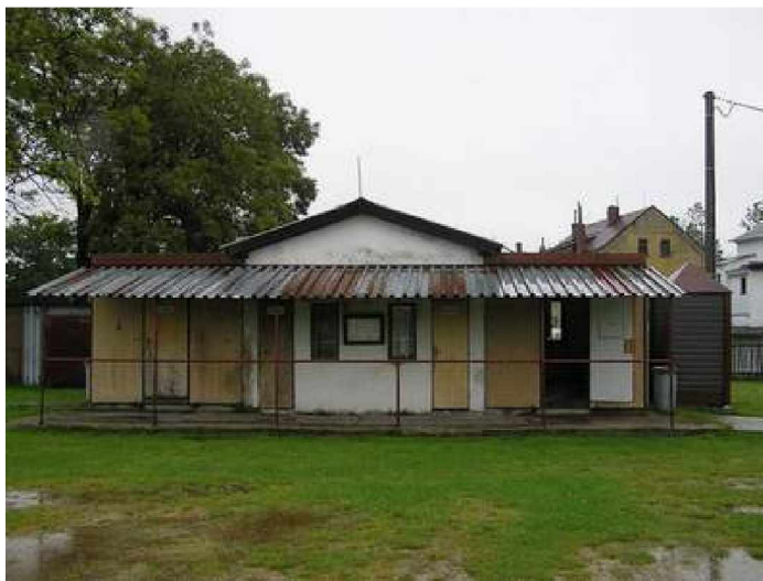
FOTO původního stavu (čelní pohled)
